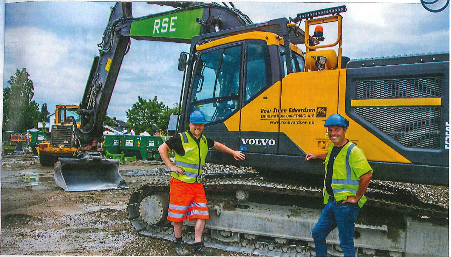
Thomas Steen Edvardsen, daglig leder og styreformann og Bjørn Weberg, anleggsleder, er travelt opptatt på anleggsplassen til det som skal bli Fredrikstad Seafoods.
